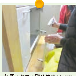
台所のドアの取り付け(小修繕)
